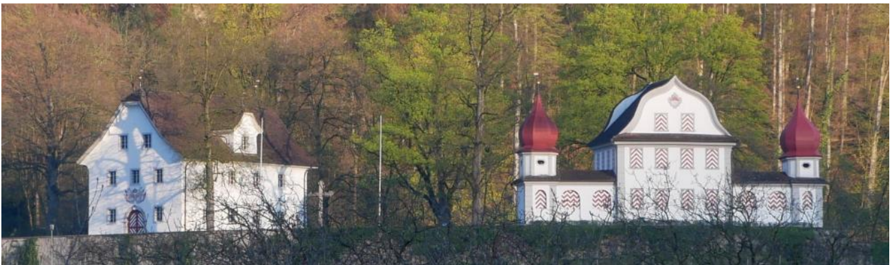
Landenberg Sarnen: Zeughaus
